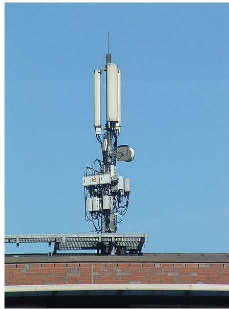
(b) 120° mobilantenn i ett cellhörn. Foto: Manfred Sauke Från Wikimedia Commons.
